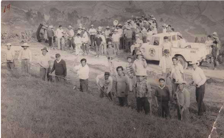
Alumnos, comunidad, profesores y miembros de SINAMOS trabajando en el mejoramiento de la carretera San Miguel – Chepén
